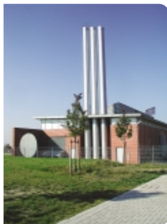
Centrale de cogénération
